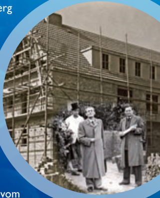
Foto: Hans Knöll bei ersten Bauarbeiten am Beutenberg (1950/1951)
